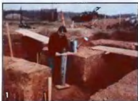
Изготовление противопучинной подушки.
