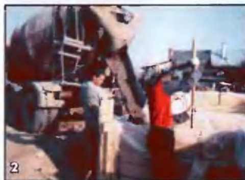
Укладка бетона в опалубку.
