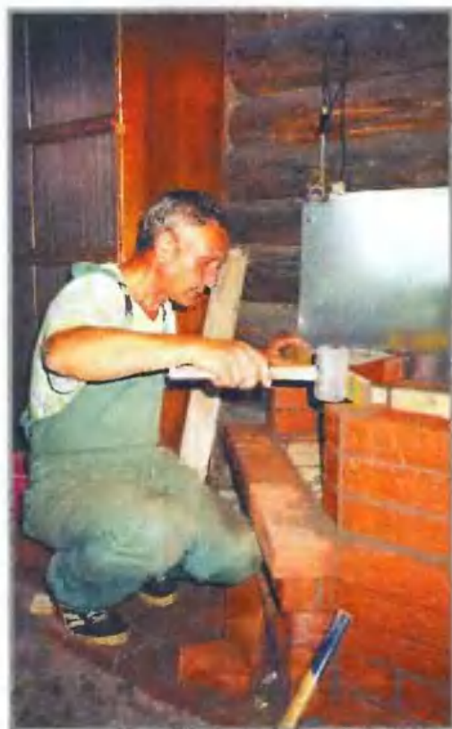
Проверка горизонтали между двумя стенками камина.
