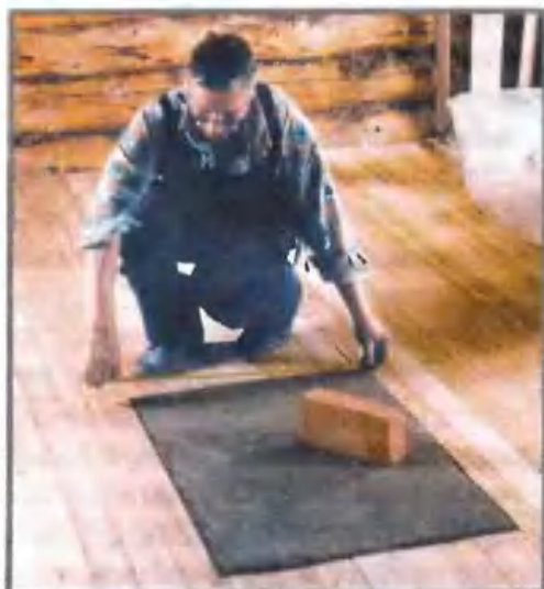
Работа начинается с изготовления фундамента «Шведки».
