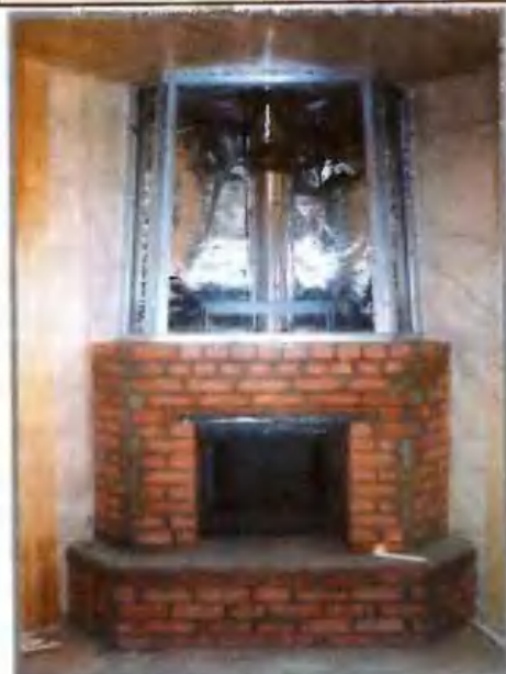
Камин на стадии работ по теплоизоляции дымохода.
