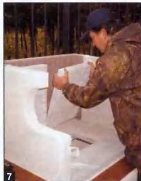
7 После установки всех стенок очага монтируются задние плиты футеровки.
