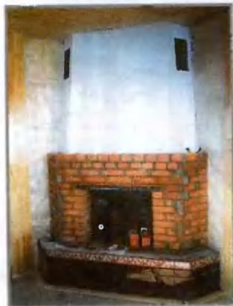
Облицовку камина плиткой начали с основания.
