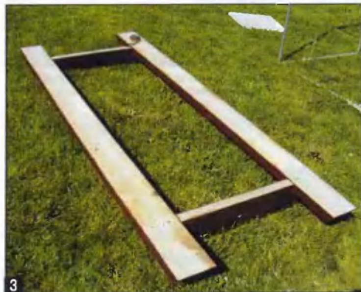
Каркас крыши лучше всего смонтировать на земле.
