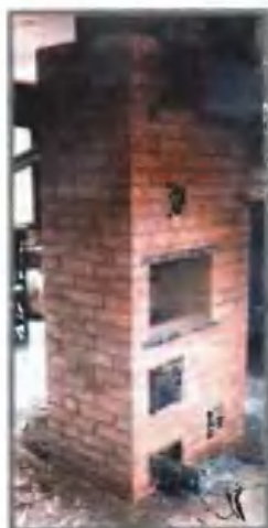
Стандартную печь «Шведку» на первом этаже выложили в соответствии с официальной документацией.
