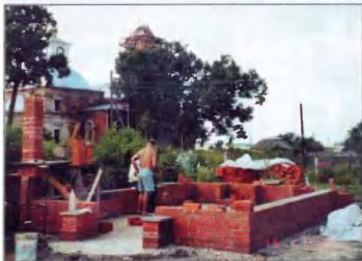
Рабочий момент стройки. На уже готовый цоколь поставлена первая колонна.
