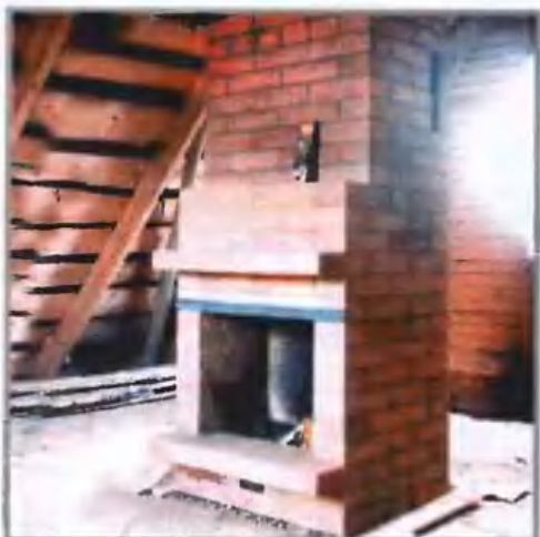
Проверка тяги камина после просушки кладки.
