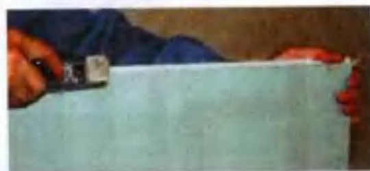
Маленьким рубанком гипсокартонную деталь легко подогнать точно по месту или закосить кромку под последующее шпатлевание шва.
