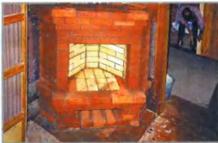
Закончена основная часть камина: сложена ниша для дров, сформирована камера сгорания и портал камина.
