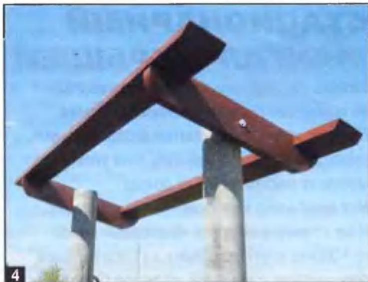
Каркас крыши занял своё место на стойках.
