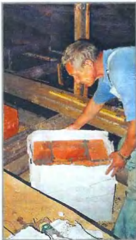
Так как балки перекрытия мешали разделке трубы, её пришлось сначала обернуть листовым асбестом толщиной 5 мм.
