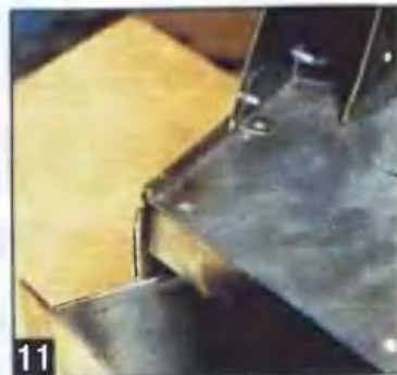
11 Собранный колпак топочной камеры устанавливают на подовую плиту и крепят к ней заклепками.
