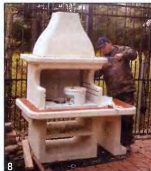
8 Дымовой колпак размещён на карнизе. Кладочный шов между колпаком и карнизом расшивают, удаляя излишки клея.
