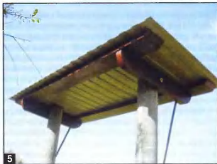
Установлена кровля и подкосы, удерживающие крышу в нужном положении.
