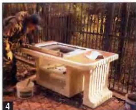
4 Проверка правильности положения подовой плиты с помощью строительного уровня.
