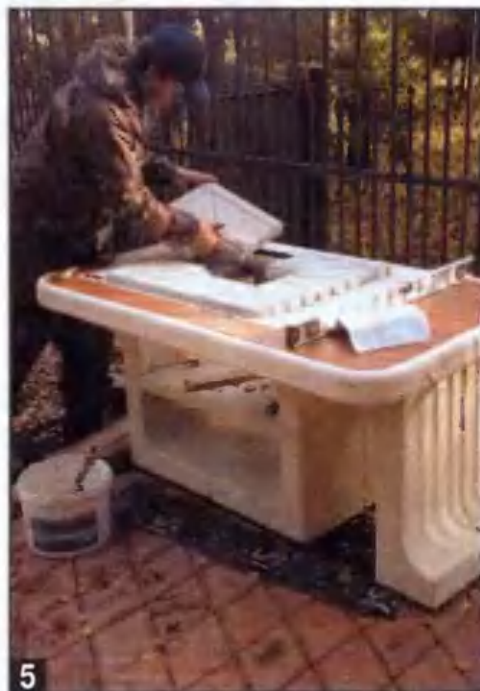
5 На подовую плиту укладывают плиты футеровки очага, в середине которых будет размещена колосниковая решётка.
