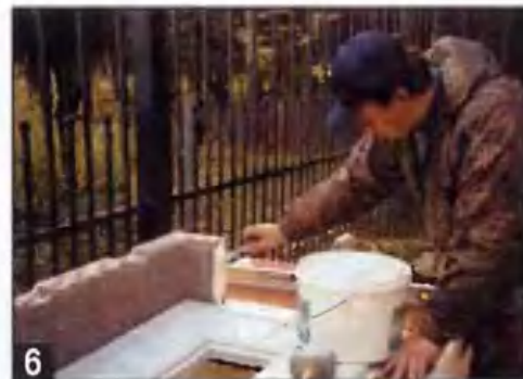
6 Установлена нижняя часть задней стойки очага. Очередь — за правой стенкой.
