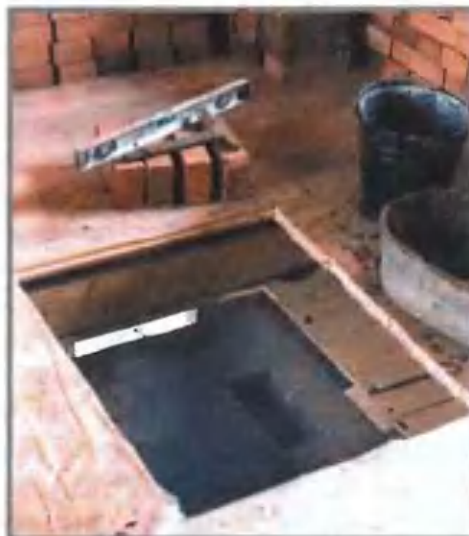
Над дымоходом, возведённым под перекрытие «Шведки», на полу мансарды был размечен проём.
